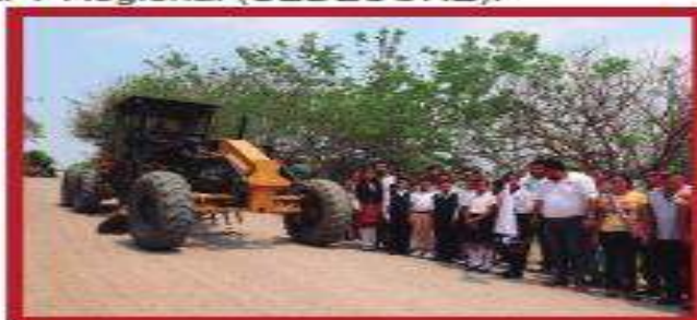
Arranque de trabajos rehabilitación de carretera Tanjasnec-Tocoy.
