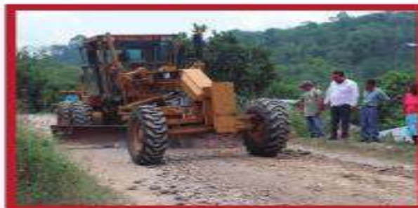
Avance de obra 80 %
