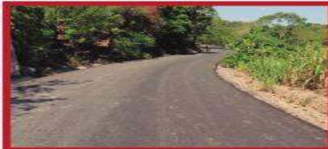
Avance de obra 80 %
