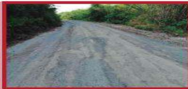
Avance de obra 80 %
